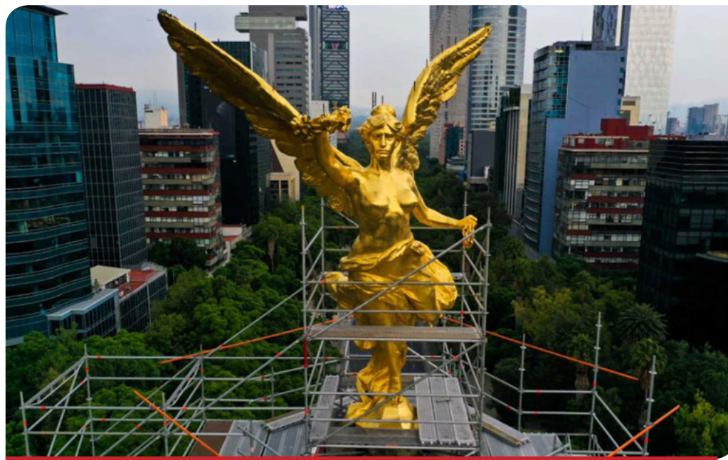
Una imagen de los trabajos de rehabilitación en el Ángel de la Independencia. A la derecha, la jefa de Gobierno, Claudia Sheinbaum durante el recorrido por el monumento.
